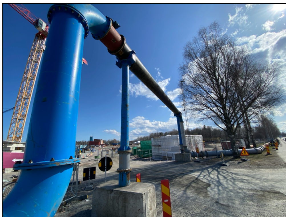
Nu byggs reningsverket ut för framtida reningskrav och fler invånare. Foto: Seppo Laine.
